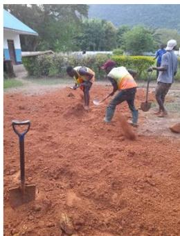
Der Vorplatz vor dem Hauptgebäude ist sehr verschlammmt. Mit dem Verteilen von einem Gemisch aus Sand und Steinen wird versucht, die nassesten Stellen trocken zu legen.
